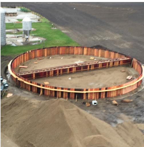
Forms up and ready to pour the walls
