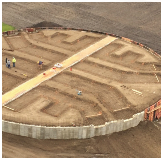
Preparing to pour air tunnels
